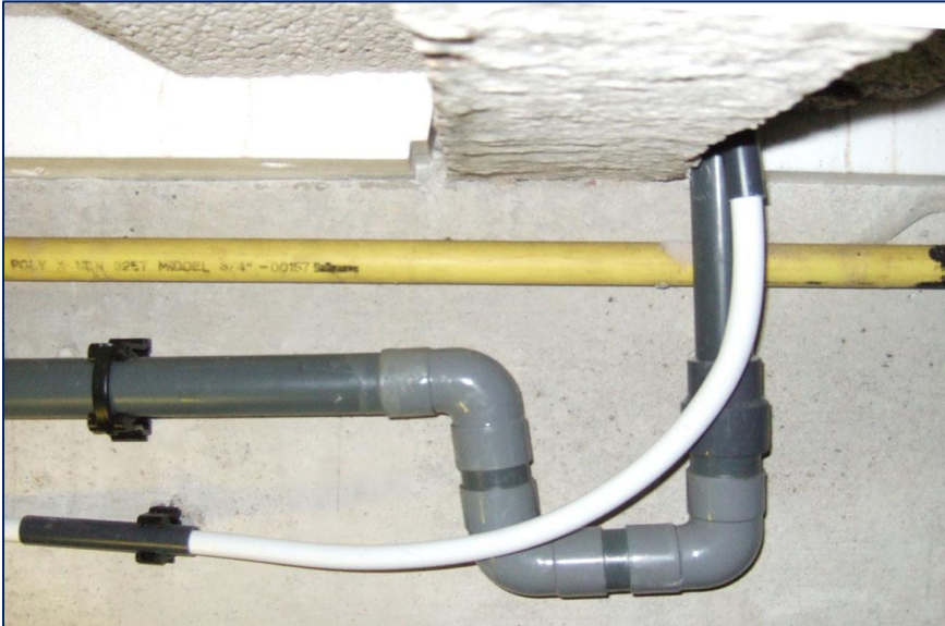
Onder in de kruipruimte is een waterslot geplaatst.
