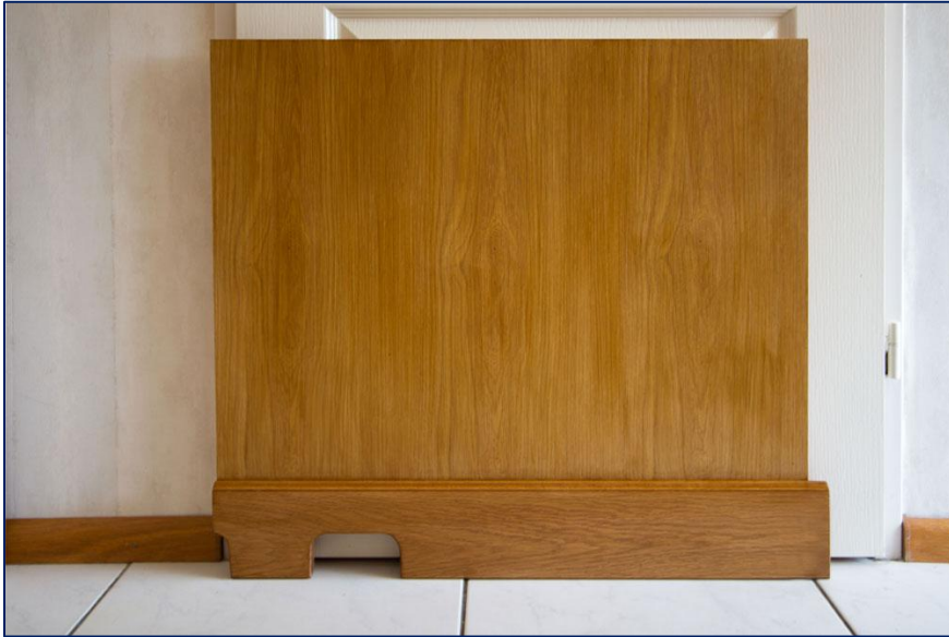
Het rechter zijpaneel, is voorzien van een gat voor de watertoevoer, afvoer en netwerkaansluiting.
