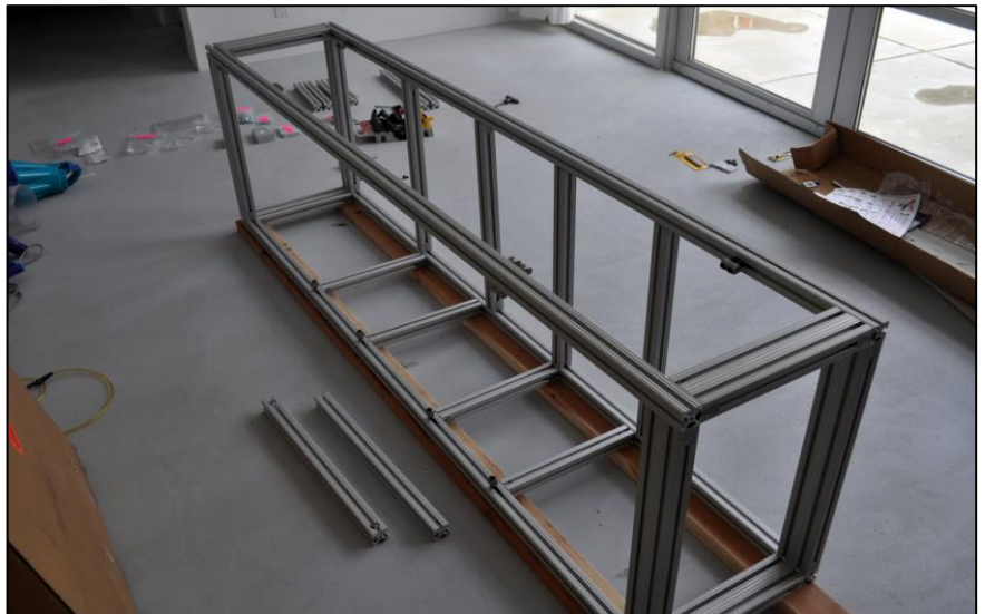
Voor het monteren van de aluminium delen zijn de onderste horizontale liggers tijdelijk op houten balken gezet, waardoor een vlakke montage mogelijk wordt.
