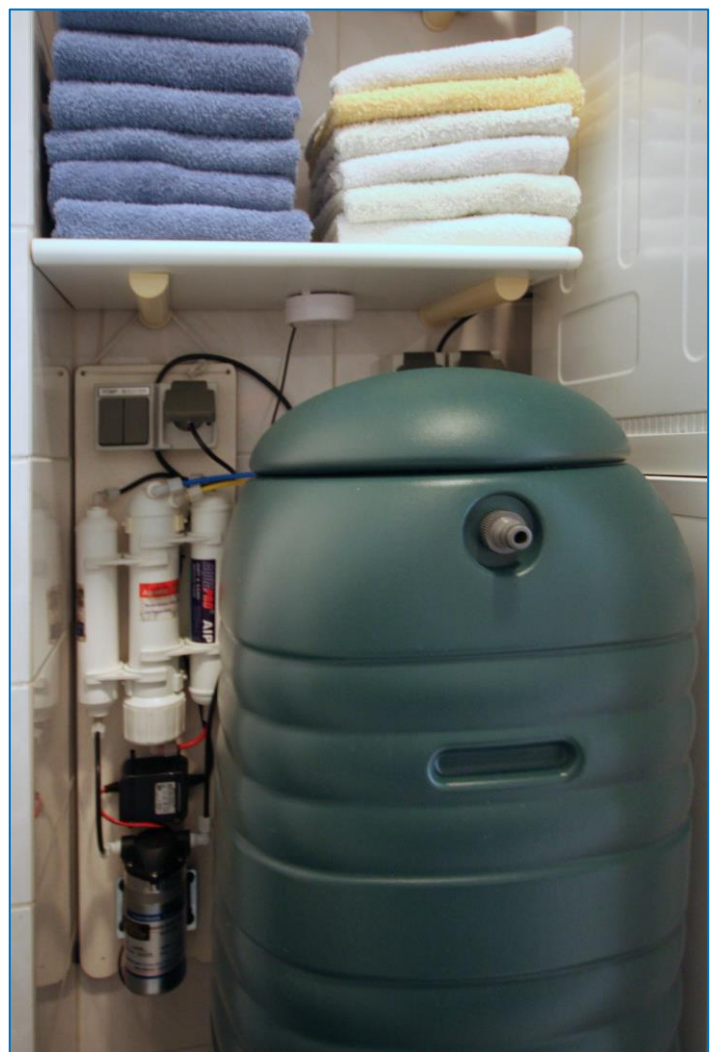
Onze installatie staat in de badkamer
