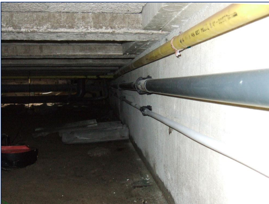
Water aan- en afvoer naar het aquarium vergemakkelijken het automatische water verversen.
