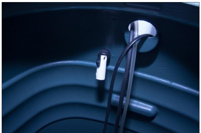
Let op! De bevestiging van de vlotterschakelaar is een perspassing dus het gat moet exact op maat zijn, anders gaat het lekken!
