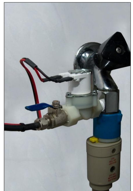
Het magneetventiel zit tussen een kraanverlenging en de mini kogelkraan.
