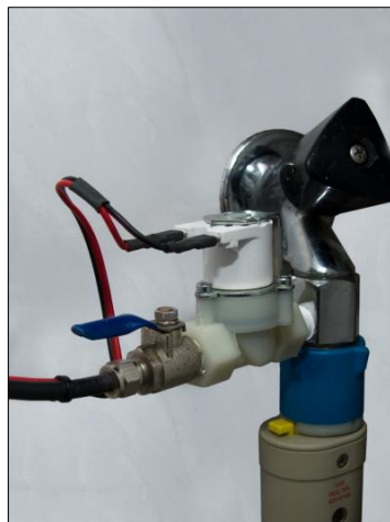
Het magneetventiel zit tussen de wasmachine kraan en de osmosekraan.
